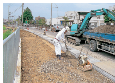
町道五領42号線 道路改良工事
