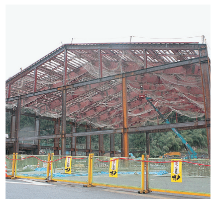
工事が進む松岡小学校屋内運動場
