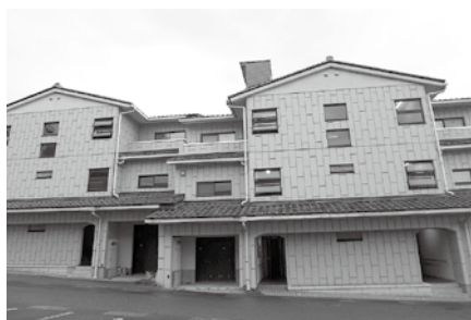
越坂団地B棟
