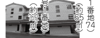
越坂団地B-1棟
