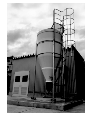
ボイラー室 外観
