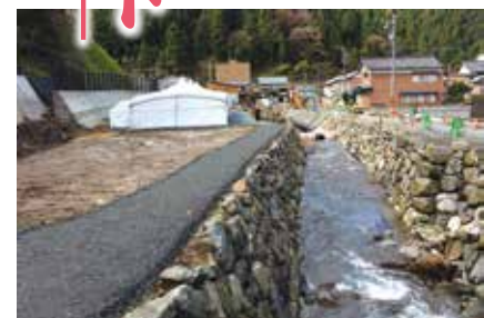
永平寺志比の建設予定地
