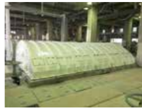
回転生物接触設備
