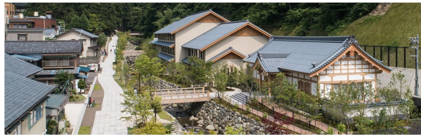
再整備された『大本山永平寺』門前地区の『旧参道』、『永平寺川』、『親善の宿 柏樹閣』
