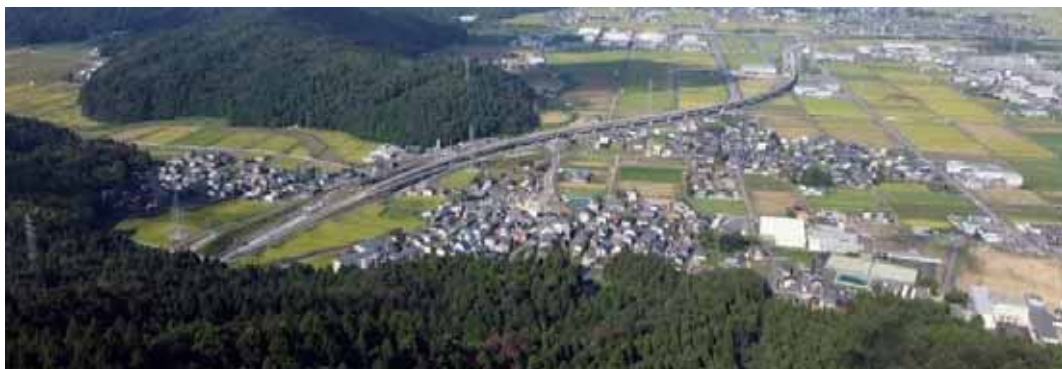
【中部縦貫自動車道の福井北JCT・IC、松岡IC付近】
