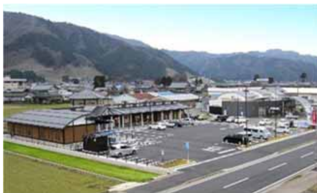
【国道416号沿いの道の駅「禅の里」】
