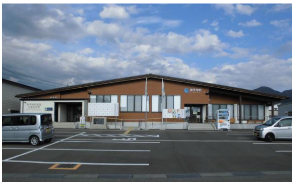
木のぬくもりのある建て替え間もない役場上志比支所
