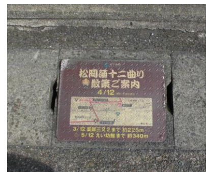
景観への配慮と見えやすさの両立が課題の道路側溝蓋を利用した路面表示
