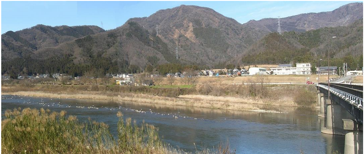
浄法寺橋（飯島側）から、浄法寺山と九頭竜川を臨む
