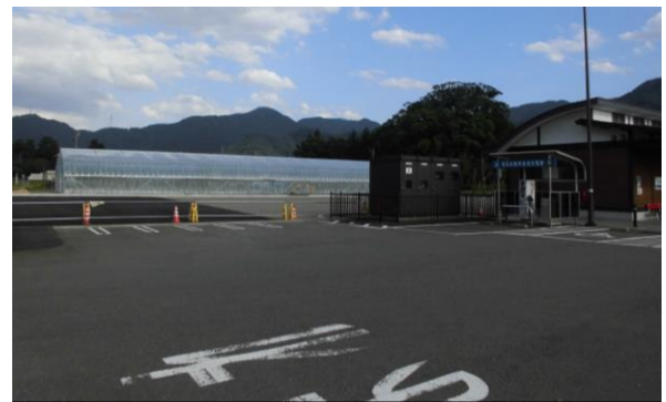
道の駅隣接地に整備されたビニールハウス農園
