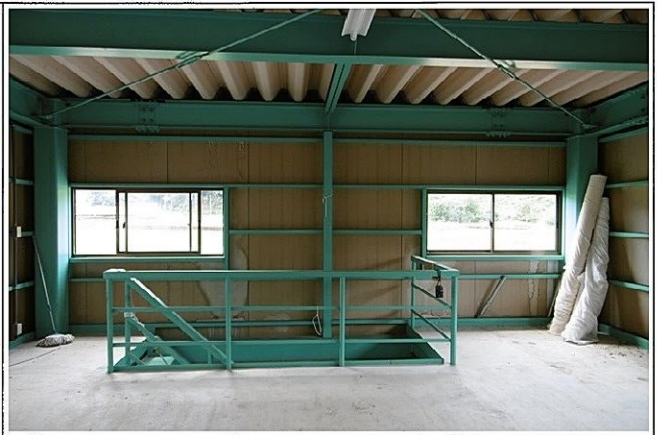
写真（鉄骨2階部・内観）
