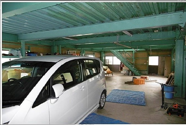
写真（鉄骨1階部・内観）
