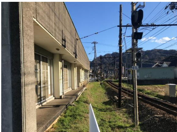
撮影方向：物件南側 西から東向き
