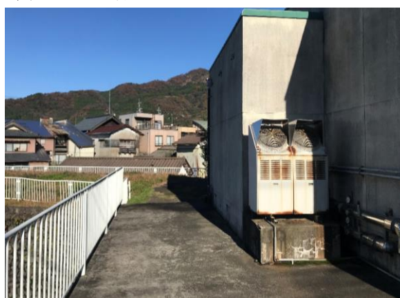
撮影方向：物件西側 南から北向き
