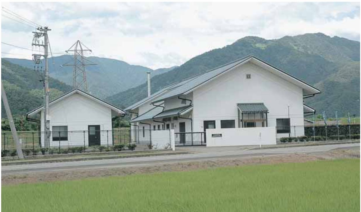
下水処理場（上志比地区）
