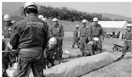
土のうをシートで包み、防水効果を高める積み土のう工法
