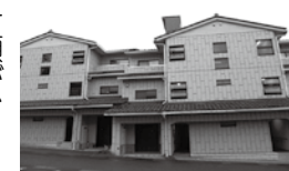
越坂団地B-1棟
