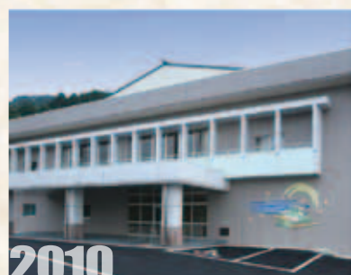
2010 松岡小学校体育館が完成
