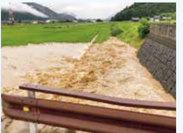
轟大谷川 溢水
