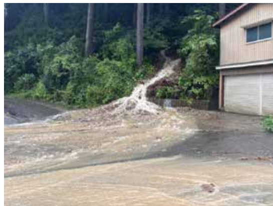
町営第1駐車場(志比) 土砂流出
