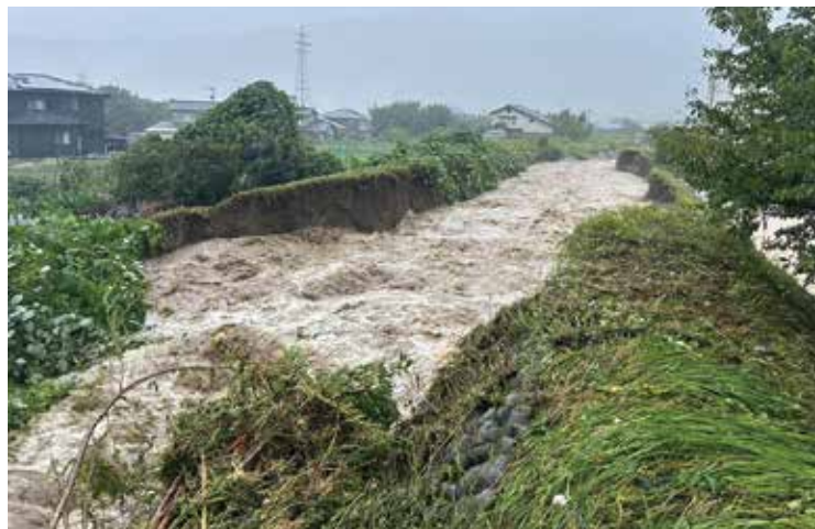
越水寸前の南河内川
