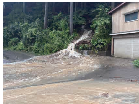
町営第1駐車場(志比) 土砂流出
